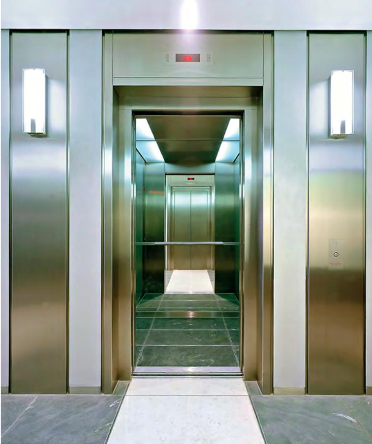
Actualmente también hay acabados *rolled-on* especiales que se asemejan a las superficies esmeriladas o chorreadas con granalla. Las superficies *rolled-on* son acabados de fábrica, producidos con un gran nivel de consistencia, y la micro-rugosidad del acero inoxidable sigue siendo básicamente la misma que la de los acabados lisos. Estas superficies ofrecen una buena limpieza (en aplicaciones interiores) y la lluvia también las lava de manera eficiente (en aplicaciones de tejados).
